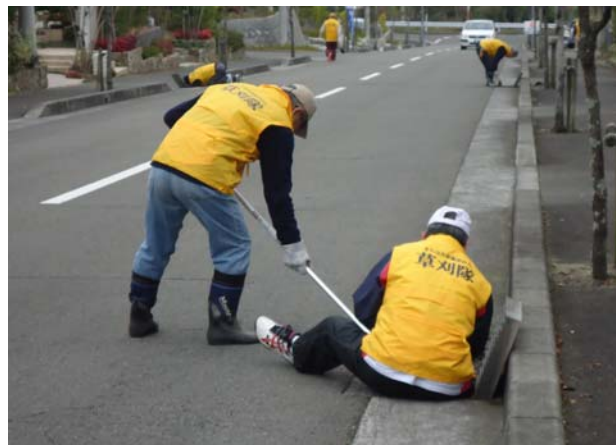
道路の側溝清掃
