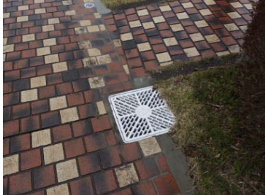
新しく設置した排水マス
