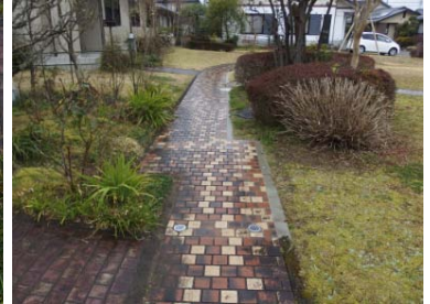
排水改善部全景
