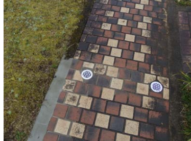
新しく設置した排水口
