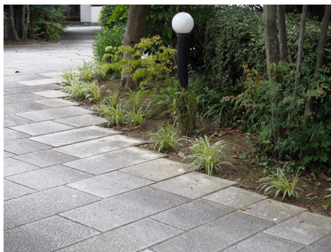
写真1. 自然石舗装拡幅部分（白い石の部分）
