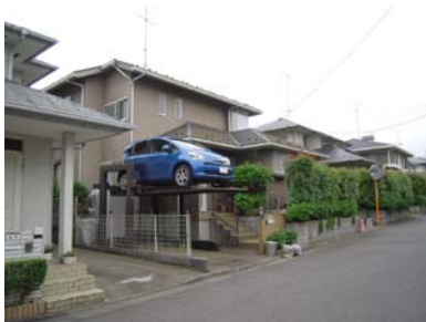
駐車場増設と門柱撤去の改修
