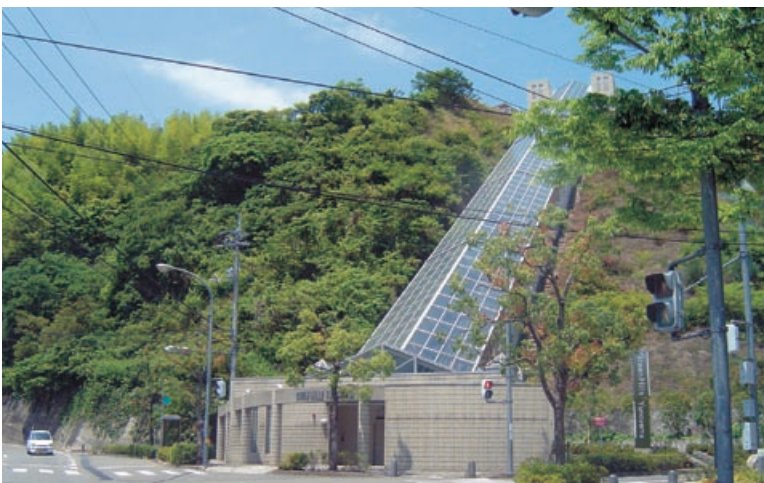
写真7 斜行エレベーター（事例4）
