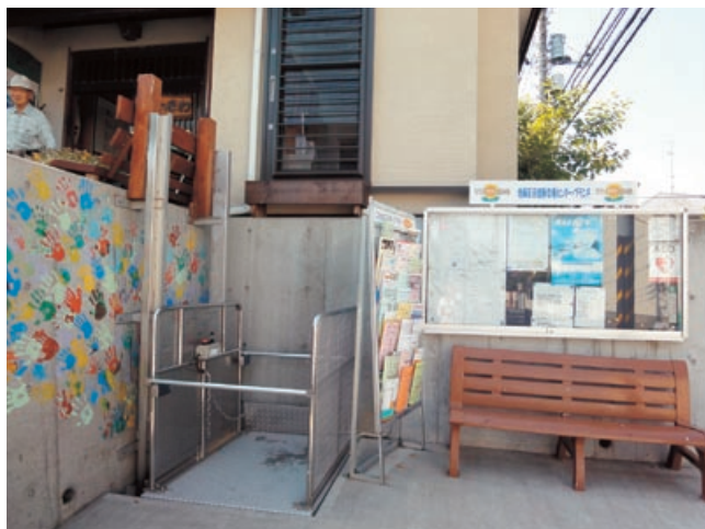
写真2 車いすの人がアプローチできるように改修
