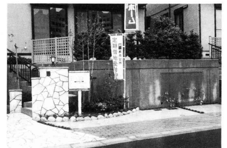
素材の違いで表情をみせる門柱付近の床面とメッシュをかけた擁壁
