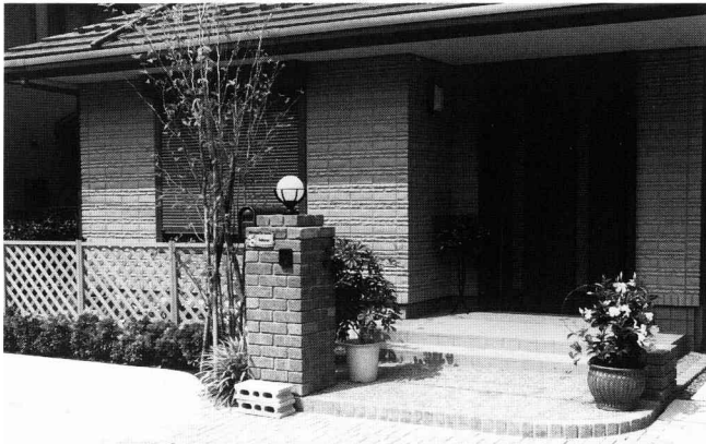
門柱と花鉢台はレンガ積みとしてガレージベイブランダムミック敷きの床面と調和させている
