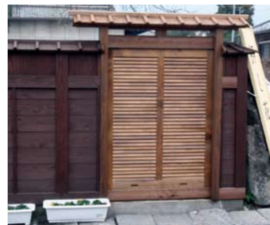
写真3 電線地中化によるトランス置場の目隠し工事
